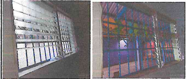
Foto 8: Vidrios de ventanas
