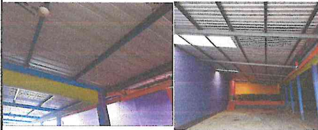
Foto 9: Sistema eléctrico del corredor, salones y patio.
