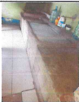
Foto 3: Falta de repello y cernido en estufa rural
